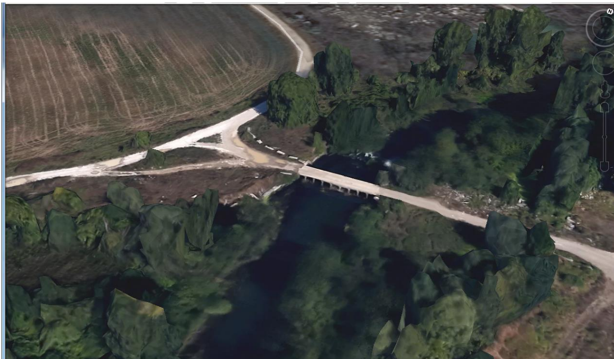
Мост на р. Огоста, западно от Долно Белотинци, в близост до площадката на „Монолит“ АД.
